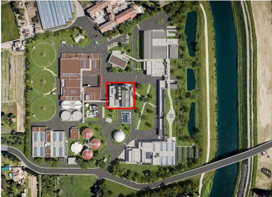
Figure n°6. Situation de l'unité de valorisation énergétique au sein de Maera (après travaux)
