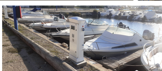
INSTALLATION DE BORNES ÉLECTRIQUES AU PORT
