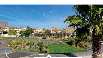
CRÉATION DU PUMTRACK
