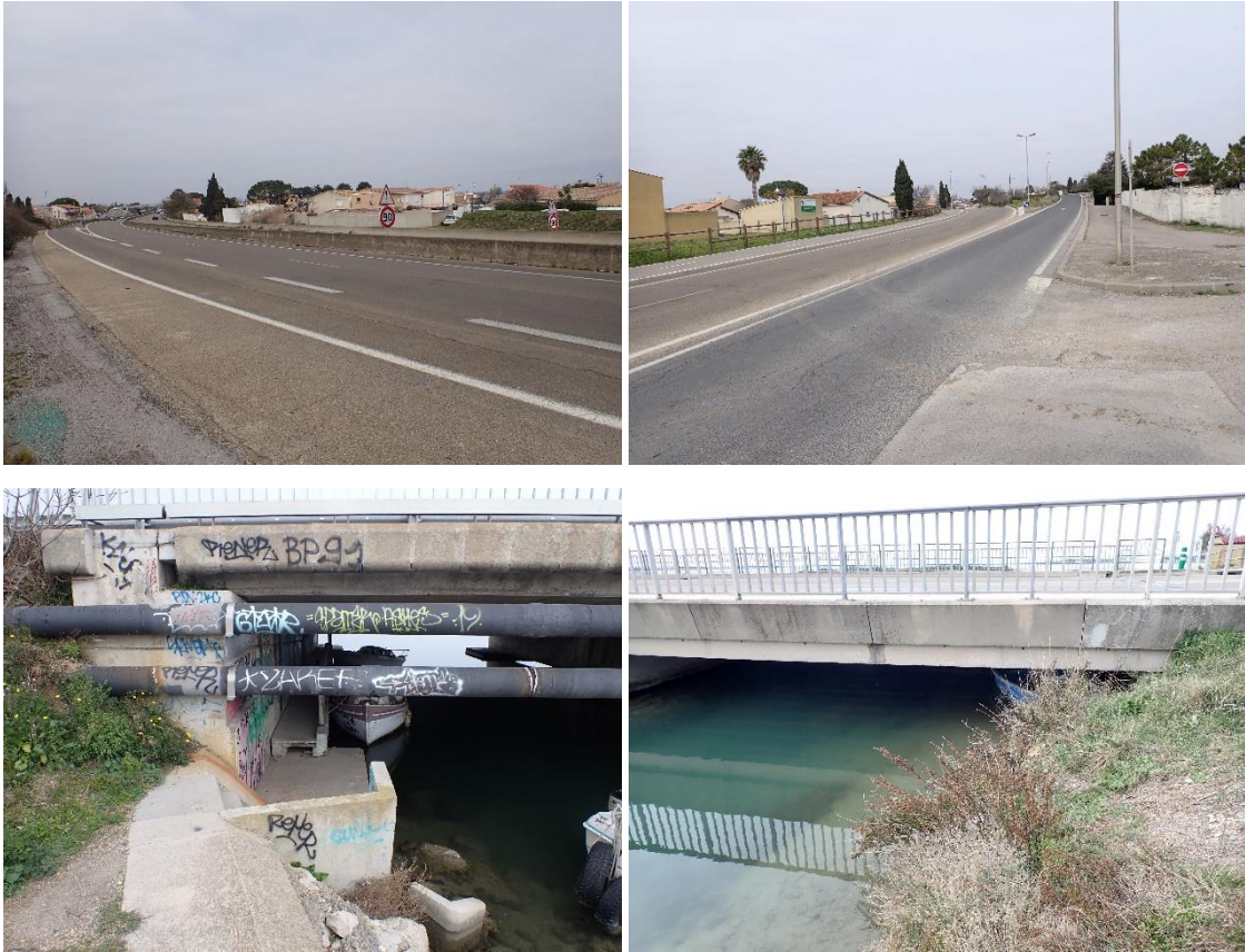
Photo 11 En haut, de gauche à droite, la D21 à l'est du site et à l'ouest du site ; en bas, à gauche, passage terrestre sous la D21 (4 voies) à l'est du site et à droite, pont de la D21 (2 voies) à l'ouest du site
