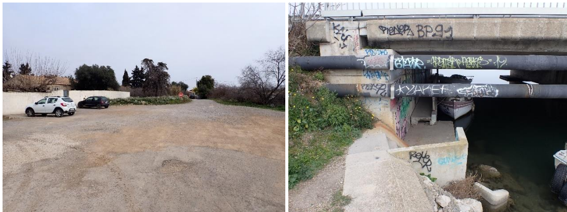
Photo 5 À gauche, parking et habitations et à droite, présence de Parietaria judaica entre la chaussée et les canalisations
