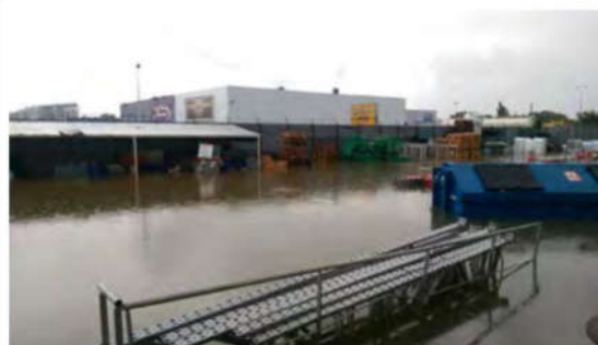
Inondation Fenouillet Septembre 2014
